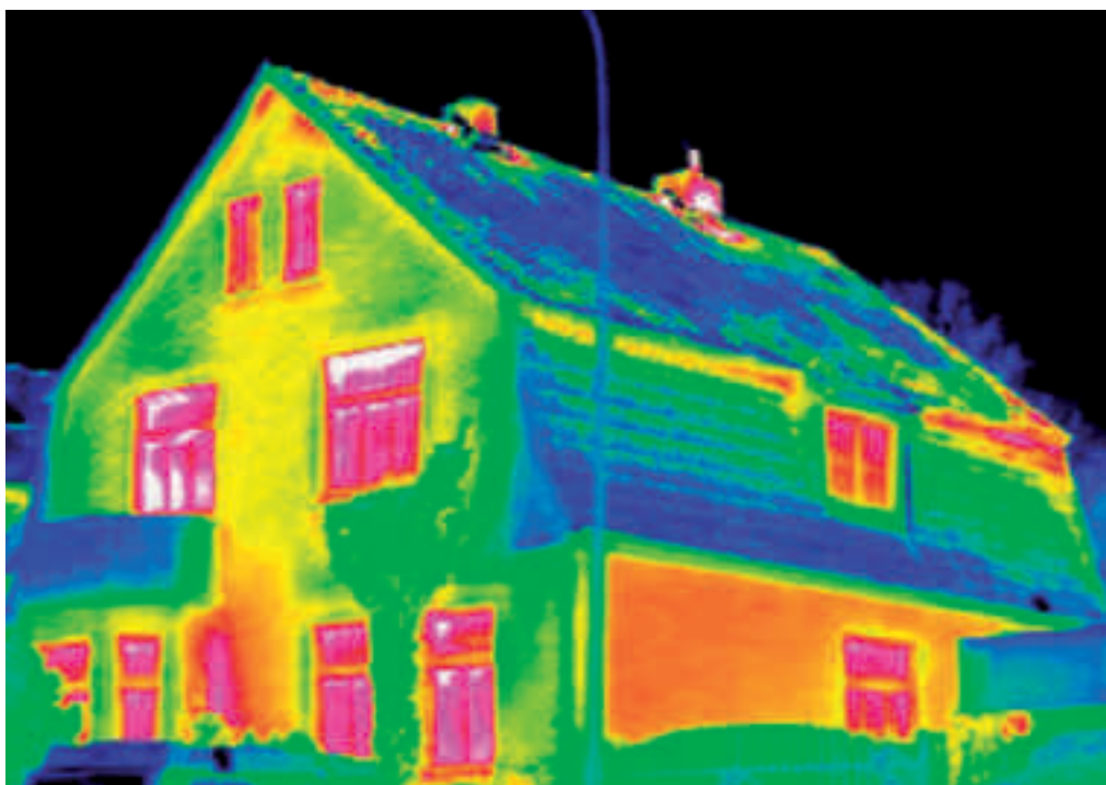
Ces dernières années, les habitations ont souvent fait l'objet d'investissements visant à limiter les déperditions de chaleur (isolation, pose de double vitrage, ...). Cela signifie que les installations de chauffage et les radiateurs sont généralement surdimensionnés et que la basse température peut être installée.
