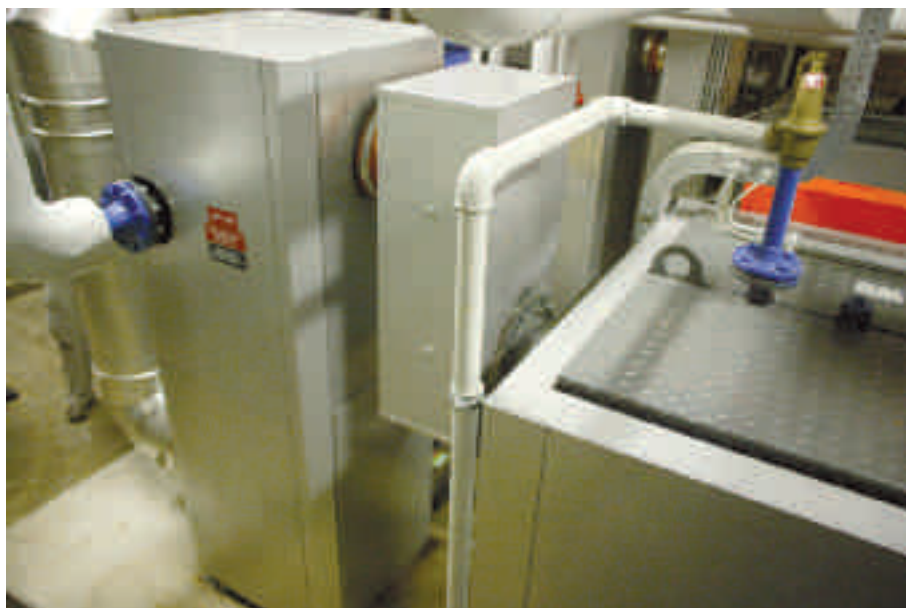
Il est tout à fait possible de bénéficier des avantages de la condensation pour les installations de grande puissance grâce à un échangeur de chaleur à condensation mazout (à gauche sur la photo).
