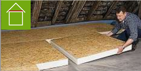
Isolation du grenier Dämmung der obersten Geschosdecke
