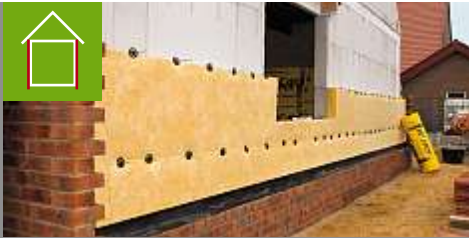
Isolation extérieure Außenwanddämmung
